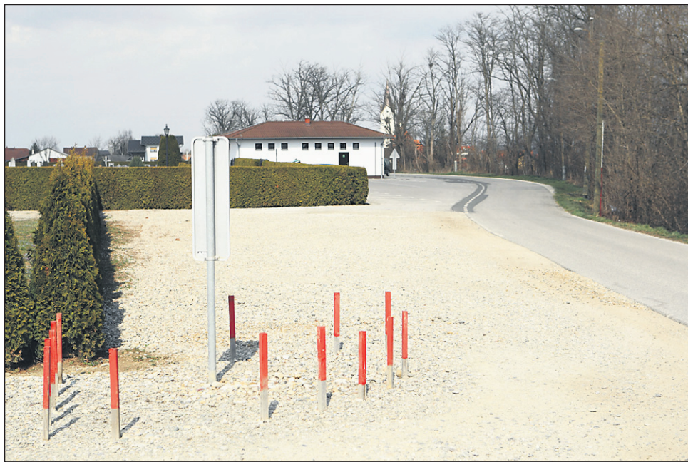
Izgradnja pločnika z razsvetljavo od središča v Zgornji Hajdini v smeri pokopališča do železniške proge bo stala 180 tisoč evrov.
