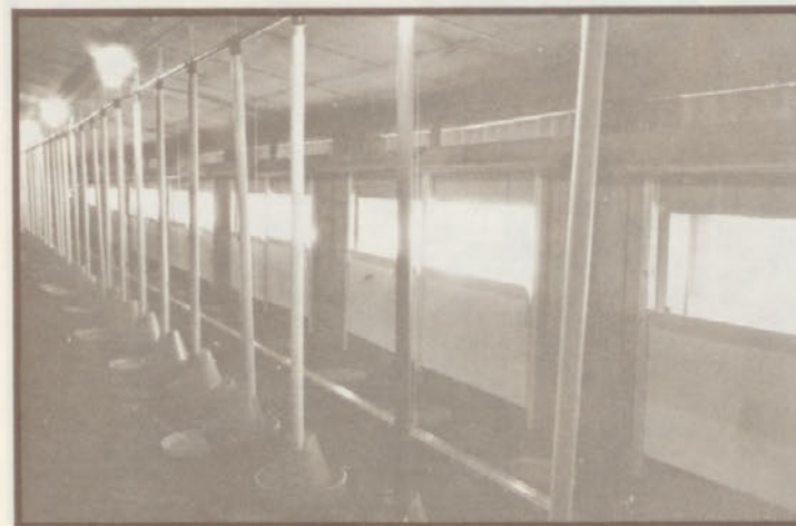
Drugi objekt z enakim načinom ventilacije – ventilatorji 8-krat presegajo možnosti dovoda zraka v objekt, kar ima za posledico ustvarjanje podtlaka v objektu in posledično pomanjkanje kisika.
