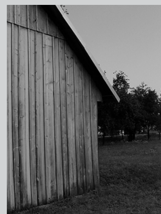
□ Slika 7. Na vertikalno postavljenih letvah na fasadi voda hitreje zdrsne kot na horizontalnih letvah
