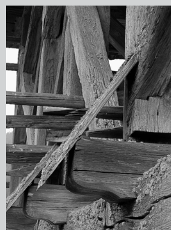
□ Slika 9. Zaščita prečnega prereza lesa, kjer les vsrka veliko vode, ki se zelo težko izsuši
