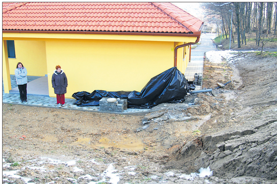
Nekaj sto kubičnih metrov drseče in razmočene zemeljske gmote je od hiše Bojana Erjavca pod plazom oddaljenih le še slaba 2 m; lepo se vidi, kako je tlakovce že dvignilo.
