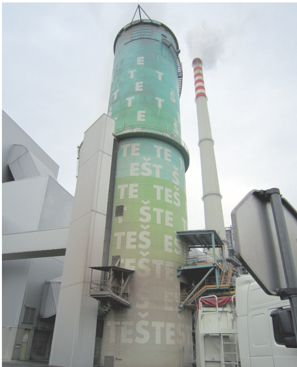
Dimniki v Termoelektrarni Šoštanj, ki s svojimi izpusti prispevajo k globalnemu segrevanju podnebja. (Foto: J. Roškar)
