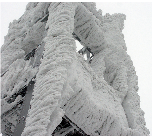
Slika 12. Posledica prehajanje nizke oblačnosti čez Javornik je tudi več kot pol metra dolgo ivje na stolpu na Javorniku 24.1.2010 (Foto: M. Gustinčič)
