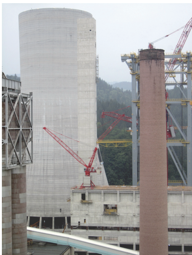
Gradbišče 6. bloka TEŠ-a. (Foto: J. Roškar)
