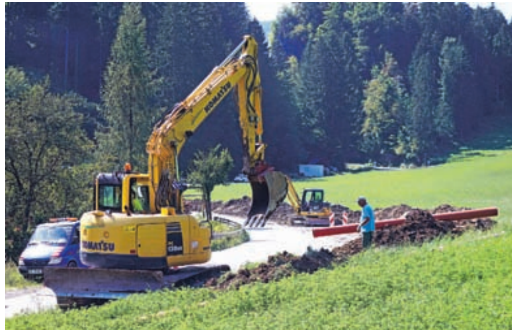
V Florjanu poleg ceste posodablja še kanalizacijsko in vodovodno omrežje.
