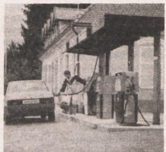
STARA ČRPALKA NEPRIMERNA - Stara črpalka v Kostanjevici že več let ne ustreza osnovnim ekološkim in varnostnim zahtevam, zato je strah krajanov, da bodo črpalko zaprli, upravičen. (Foto: T. G.)
