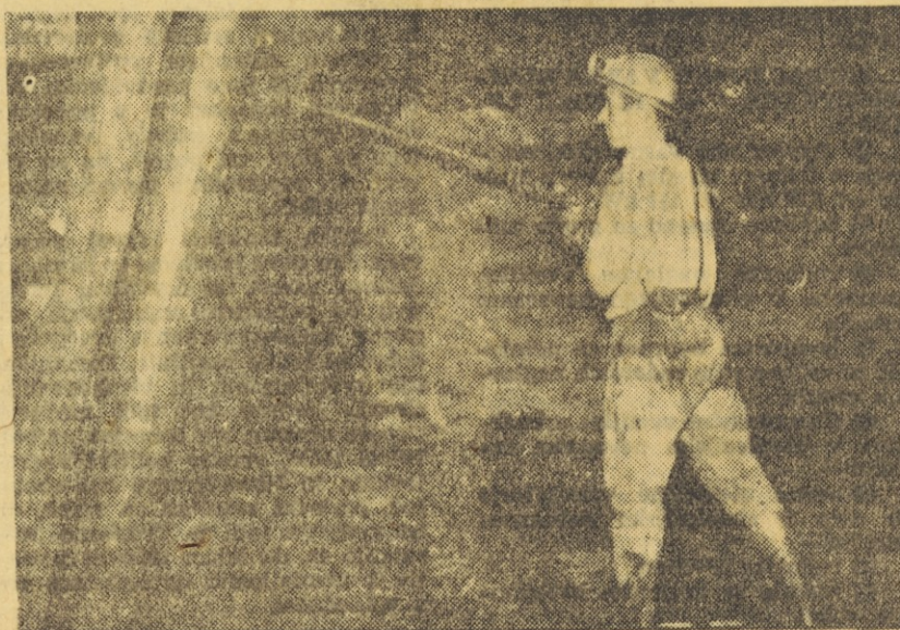
Vrtanje na odkopu v Rudniku Zagorje
