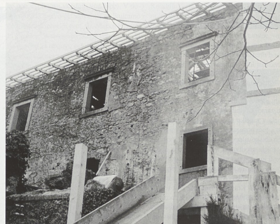
Zahodni del zgornjega palacija ob Kvadratnem stolpu dobiva ostrešje.
