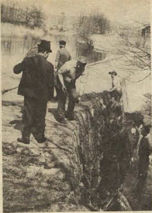
Kočevski ribiči so začeli s prostovoljnim delom popravljati jez na bregu in strugo Rinže. Prvo delovno akcijo so organizirali 24. marca, drugo pa bodo predvidoma 14. aprila. Pomoč v materialu ali denarju sta obljubili ribičem tudi krajevna skupnost in občinska skupščina. (Foto: Prime)
