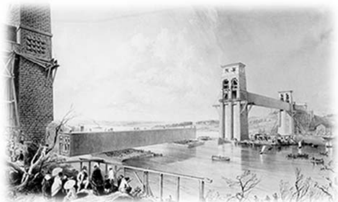
Gradnja cevne konstrukcije na kopnem in splavljenje na mesto dviga
