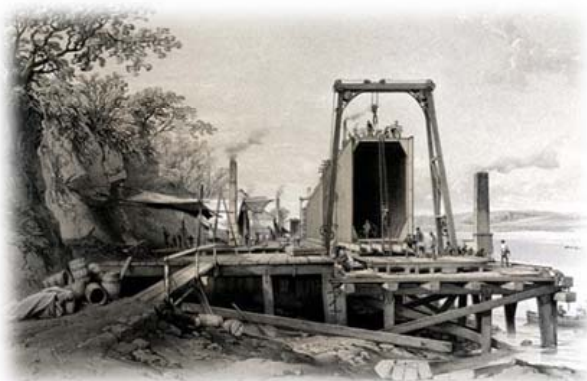
Gradnja cevne konstrukcije na kopnem in splavljenje na mesto dviga
