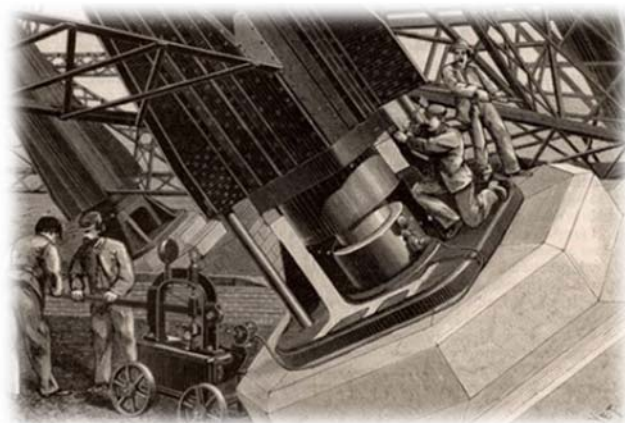
Slika 9 : Poravnavanje ploščadi Eifflovega stolpa med njegovo gradnjo (La Nature, Paris, 1888)
