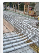
Potek kanalskih povezav nad spuščnim stropom ter v armirano betonski plošči
