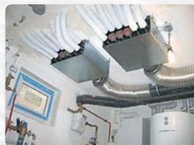
Primer povezovanja distribucijskih kanalov za prostore z glavnim dovodnim in povratnim razdelilecem
