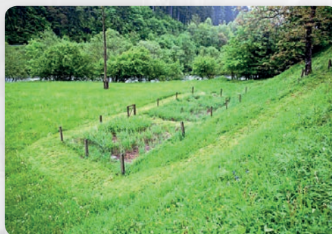
Mala komunalna rastlinska čistilna naprava za čiščenje odpadnih voda za nek objekt s kapaciteto čiščenja 30 PE – primer z dvema gredama
