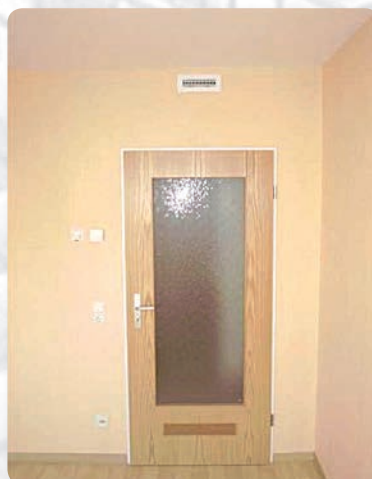
Primer dovoda zraka v prostor nad vrati ter povratek spodaj
