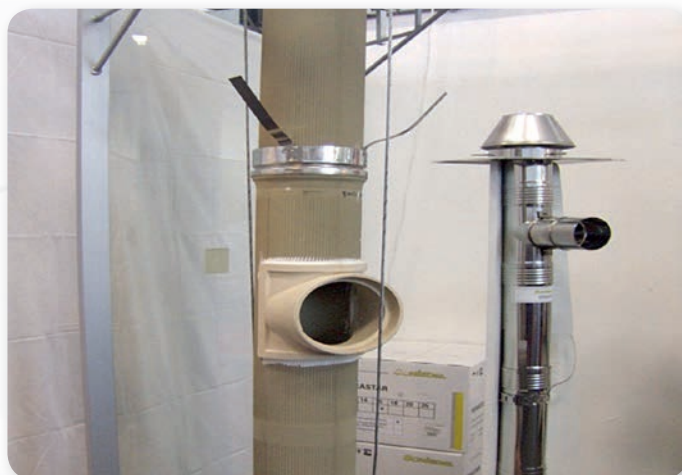
Imamo več možnosti za izbiro materialov za dimovodne naprave, to so keramični, šamotni, kovinski iz nerjaveče pločevine, drugi kombinacije kovine, plastike.
