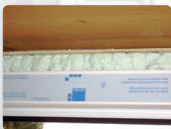
Montažna pena kot toplotni in zvočni izolator
