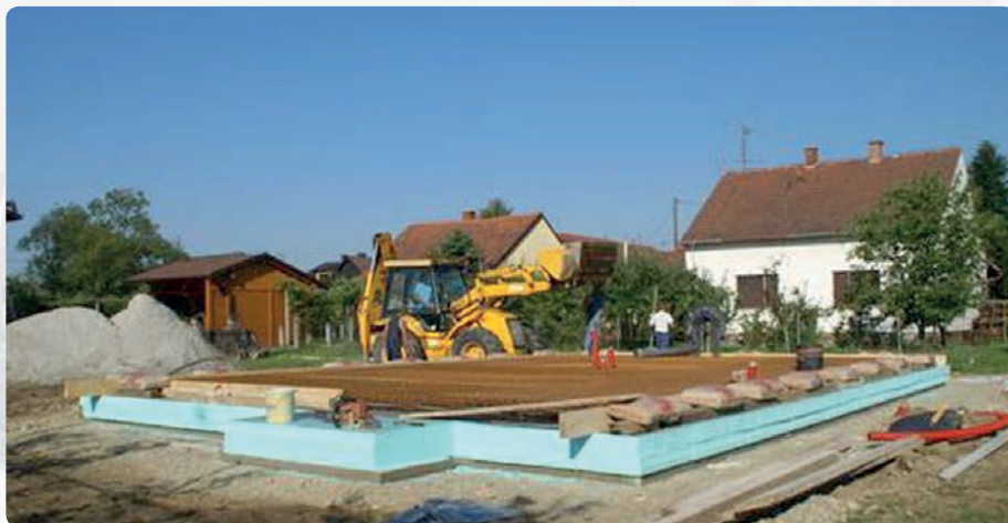
Izolacija temeljne plošče
