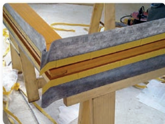
Priprava na vgradnjo - notranji in zunanji tesnilni trak v trikomponentnem sistemu
