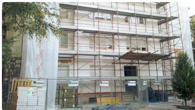
Energijska prenova večstanovanjske stavbe s kontaktno fasado
