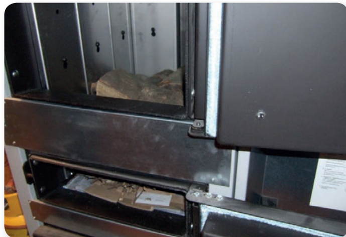
V 20 kW kurilno napravo se nalagajo polena dolžine do 55 cm
