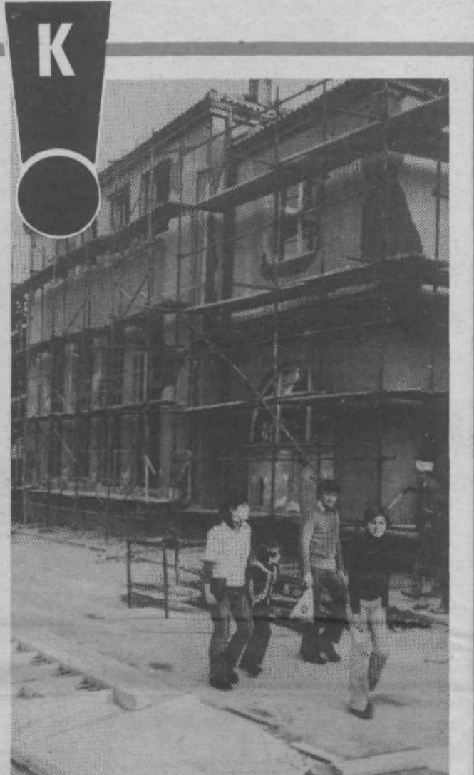
Preureditev kina Triglav napreduje po predvidenem načrtu. Zunanost bo kmalu rešena spon zidarskih odrov, pa tudi notranja dela lepo napredujejo. Za pešce je že očiščen prehod po cesti Ob Ljubljani in upati je, da bo še pred novim letom odprta cesta za motorna vozila. HVAŠTIJA
