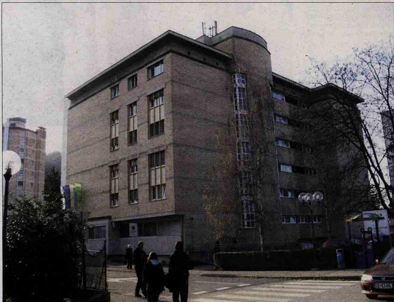
Celovita obnova t. i. novega dela Doma ob Savinji v Celju, zgrajenega pred približno tremi desetletji, bo končana v začetku pomladi. Zadnja faza se je začela v tem tednu.
