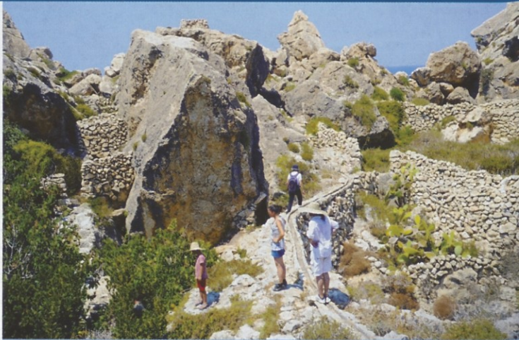
Fotografija zasnove in gradnje dveh zidov. Študentje so spoznavali težo kamna, priročnost skladanja pravih oblik in strukturo zidu iz neoblikovanih kamnov. Fotografija: Andreja Benko
