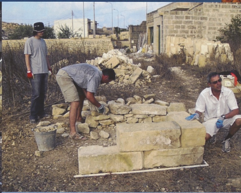
Fotografija zasnove in gradnje dveh zidov. Študentje so spoznavali težo kamna, priločnost skladanja pravih oblik in strukturo zidu iz neoblikovanih kamnov. Fotografiji: Andreja Benko
