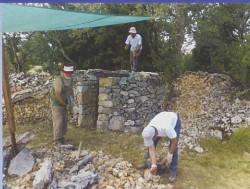
Obodni nosilni zid je končan.
