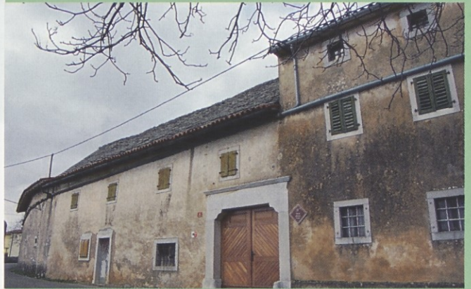
Prvotno stanovanjsko poslopje domačije z lopo, v katero se dostopa skozi s kamnitim portalom opremljen širok vhod. Vse je združeno pod enotno skrlato streho.
