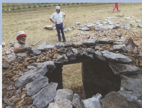
Začetek velbanja - previsevanja škrl za streho s spodkladanjem in zakladanjem.
