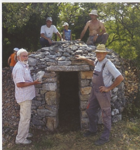
Polaganje zadnje večje škrle na vrh strehe z zadovoljnimi obrazi graditeljev.
