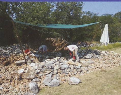
Pričetek gradnje na gradbišču.
