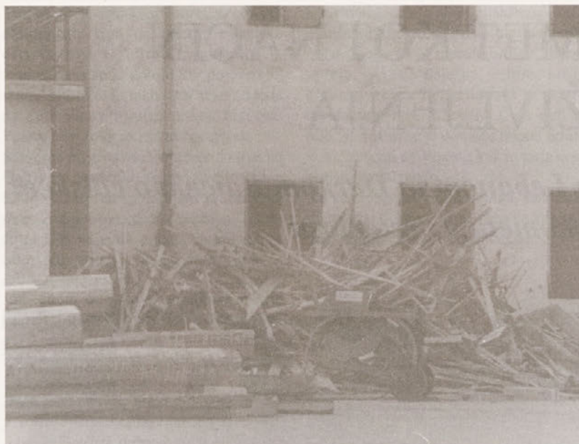
Ena redkih fotografij, ki prikazuje začetek podiranja starega šolskega poslopja l. 1984. Z odločitvijo o adaptaciji stare šolske stavbe je bilo igrišče pod šolo obsojeno na uničenje. (Foto: Arhiv Rokometni klub Col)
