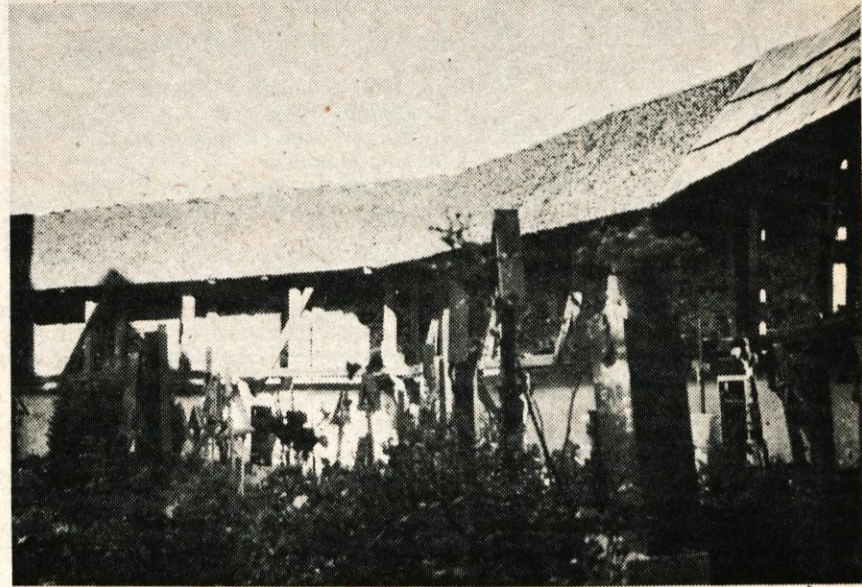
Še danes ohranjeni leseni mostovži na notranji strani obzidja »turškega« tabora na Djekšah.
