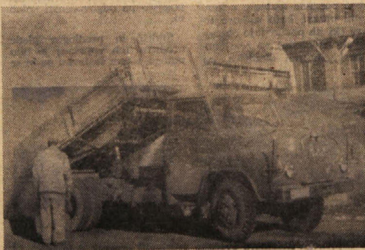
Granullran praženec iz nove pražarne transportirajo s tovarnjakom do bunkerjev ob toplinici
