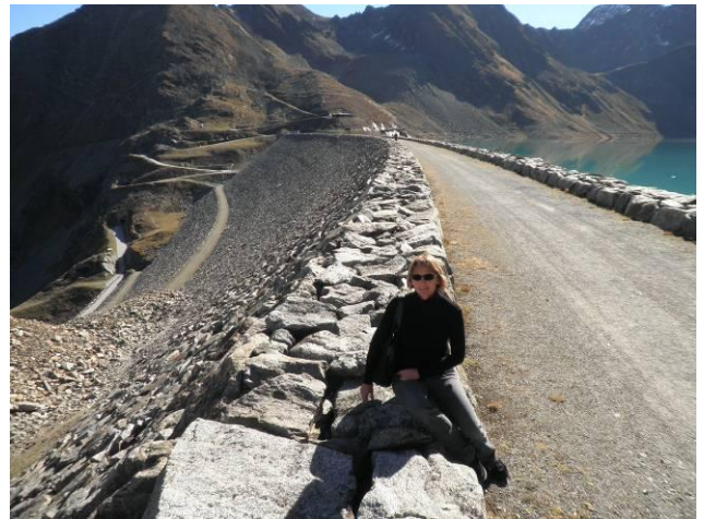
Slika 5. Krona zgornje pregrade Finstertal na koti 2325m.
