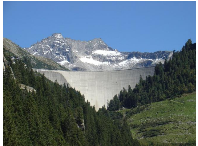
Slika 1. Pogled na ločno pregrado Zillerguendl z dolvodne strani
