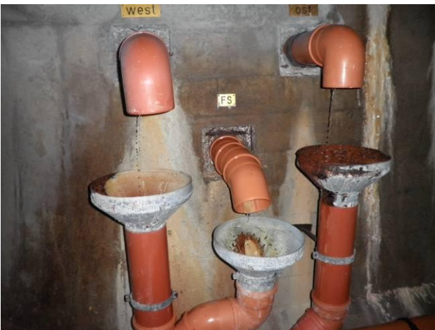
Slika 4. Kontrolni hodnik – kontrola precejne vode
