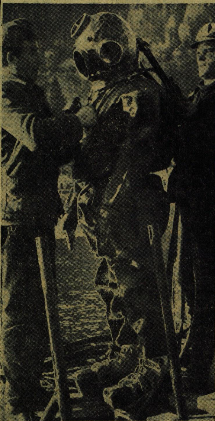
V ponedeljek so končali s prvo etapo polaganja 100 metrov dolgega cevovoda 10—15 m globoko pod jezersko gladino. V teh dneh pa bodo začeli z drugo etapo, položili bodo 300 metrov dolg cevovod. Na sliki: potapljač mariborskega podjetja »Tehnogradnja« pred odhodom na delovno mesto pod gladino Blejskega jezera, kjer sestavlja posamezne dele cevi
