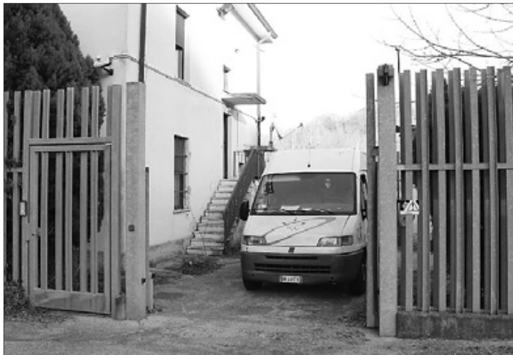
V gabrski vojašnici potekajo obnovitvena dela
