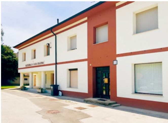
Obnova notranjosti kulturne dvorane Grajena
