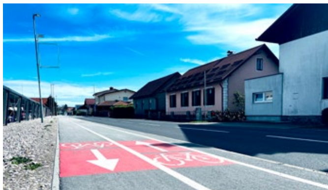
Ureditev površin za kolesarje na Rogozniški cesti: obstoječi pločnik smo preuredili v dvosmerno kolesarsko stezo, zgradili enostransko dvosmerno kolesarsko stezo s kolesarskim prehodom, uredili odvodnjavanje, javno razsvetljava in leseno brv čez potok Grajena.
