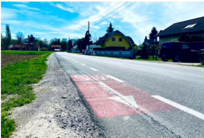
Izgradnja kolesarskih povezav na območju ceste Na postajo.
