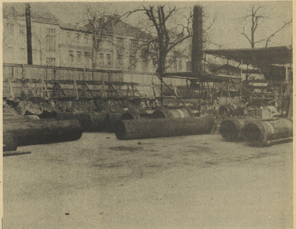
Cevi čakajo, da jih vgradijo. Črpalnice bo meter pod parkom
