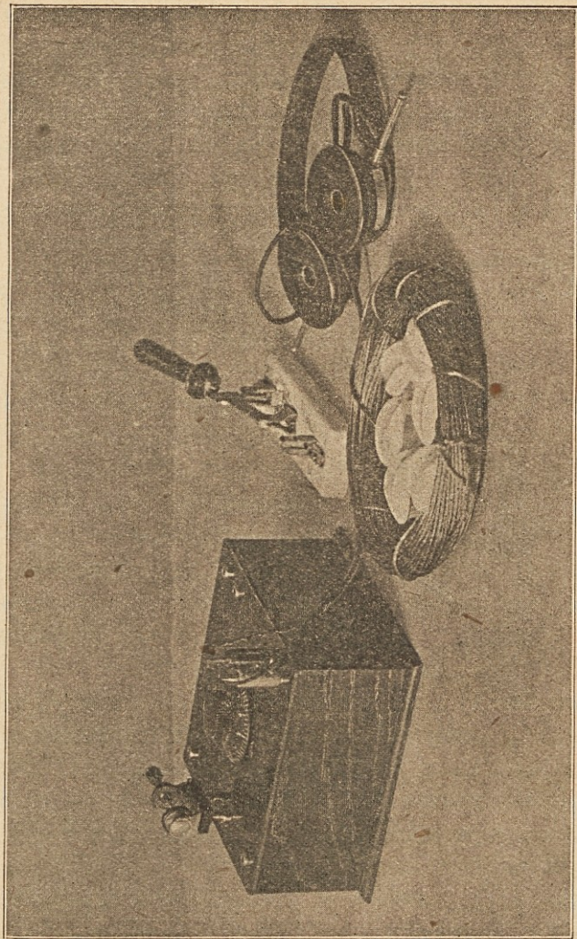
Levo: detektorski aparat z držalom za kristal, uglasčevalnim gumbom in telefonskimi stikali. V sredi: antensko pretikalo in antenska žica z izolatorji. Desno: slušalke.
