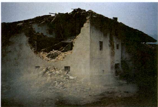
Slika 4: Potres. V letu 1976 je zahodne dele Slovenije najbolj prizadel potres, ki je imel hipocenter na severnem obrobju Furlanske nižine. Najhuje je bilo v Breginjskem kotu. Mnoge hiše (približno 3500) so bile tako poškodovane, da niso bile več varne za bivanje. Slika prikazuje podiranje - odstranjevanje v potresu poškodovane hiše v Breginju. Nekdanje izredno lepo naselje beneškoslovenskega tipa je z obnovo povsem spremenilo svojo podobo. V Sloveniji imamo kar štiri območja, v katerih pričakujemo potrese do 9 rušilne MCS stopnje, to so: Tolminsko, Idrijsko, Ljubljansko in Brežiško-Krško. (Foto M. Orožen Adamič.)
