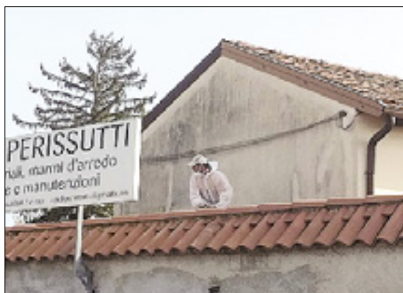
Delavec med sanacijo strehe stavbe ob pokopališču M.K.
