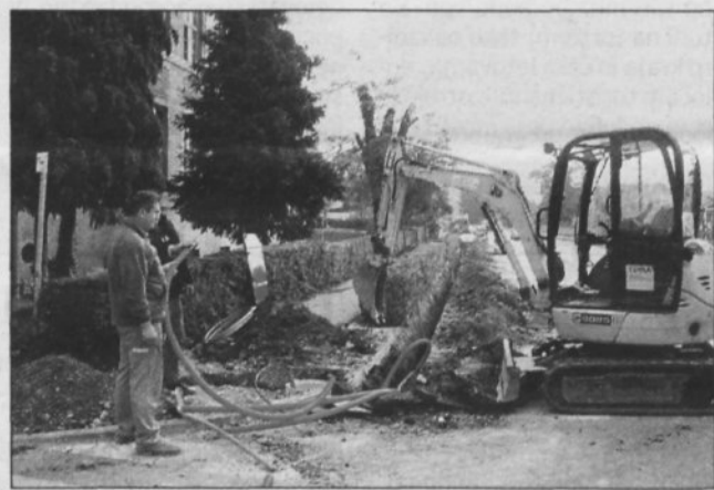
Dela na Bizeljski cesti v Brežicah, kjer ob javni razsvetljavi polagajo tudi kanale za optiko.
