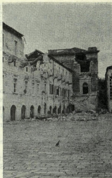
Slika 8. Porušitev zgornjih delov kamnitih hiš v Kotoru
