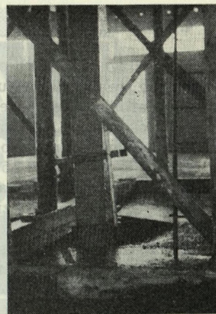
Sl. 2. Podpiranje posedle konstrukcije
