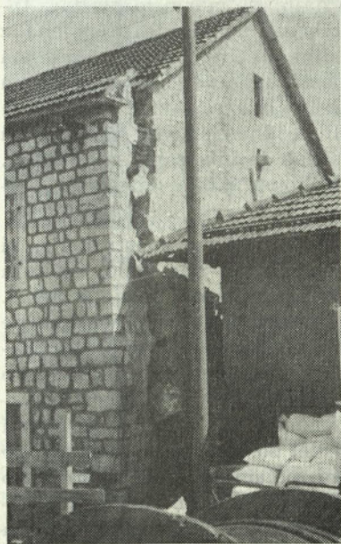
Slika 7. Začetek rušenja kamnite hiše v Kumboru
