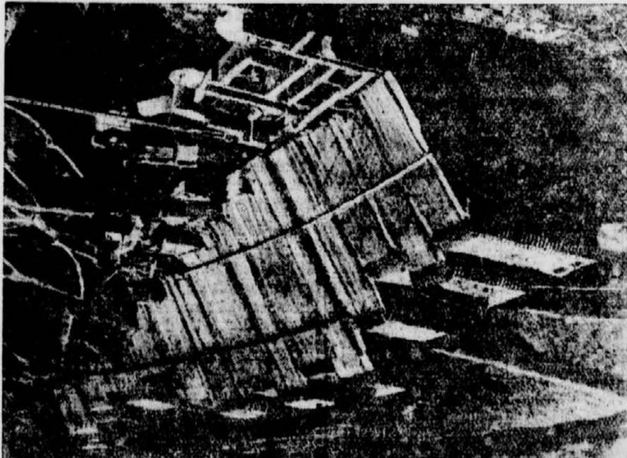
In Thüringen geht der Bau der Hohenwarte-Talsperre rüstig vorwärts. Der größte Teil der Sperrmauer, die eine Höhe von 75 Meter erreichen und die größte Europas sein wird, ist nahezu fertig. Unser Bild vermittelt einen Eindruck von der Wucht dieses Betonriegels, der in das Tal der Saale gesetzt wurde (Scherl-Bilderdienst-M.)
