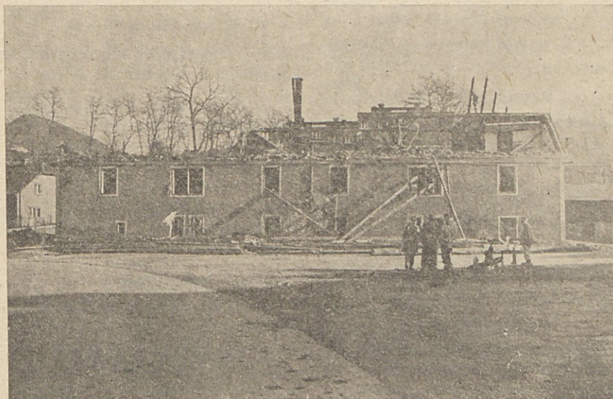
Sredi decembra 1974, so podrli zgradbo dotrajanega bivšega samskega doma na Polaju - naselje Opekarna. Na tem mestu bo zgrajen v prvi fazi nov stanovanjski blok, v okviru širše zazidave tega območja, v naslednjih letih. Ostrešje je pogodbeno odstranil s svojo skupino Muharem Kurtič, medtem ko je zgradbo porušila in pridobljeni material odvozila TOZD Avtoprevoz »Zasavje« ZPT, s svojimi delovnimi stroji in avtomobili. (Foto inž. T. Bregant)
