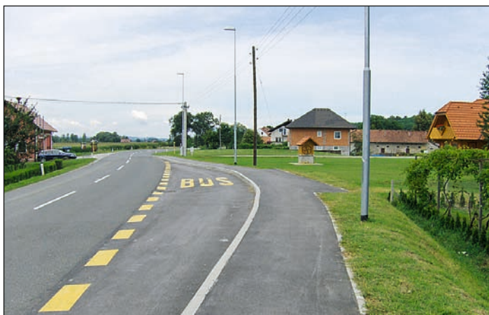
Pločnik in avtobusne postaje Obrež
