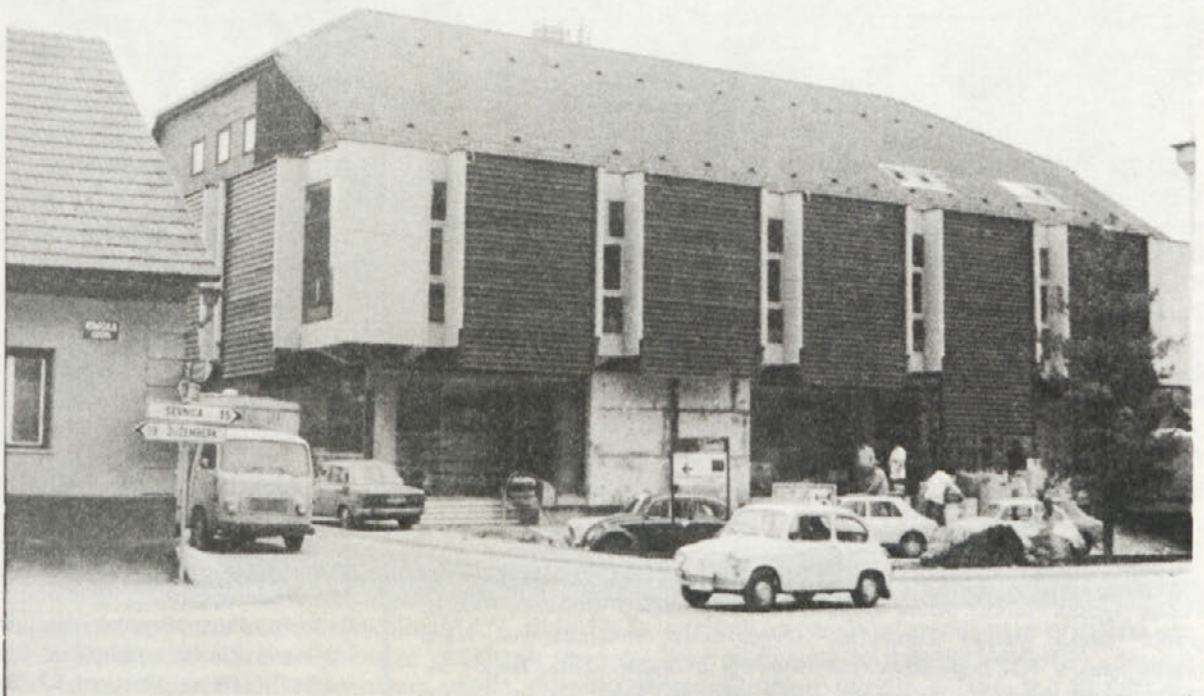
Te dni so že izročili namenu lepo, novo blagovnico Dolenjke v Trebnjem, ki jo je zgradil TOZD Gradbeni sektor Novo mesto
