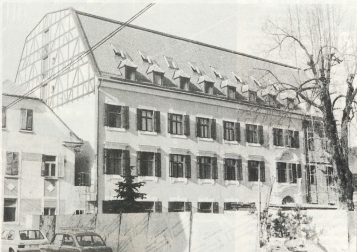
Obnovljena in preurejena stavba Zdravilišča v Dol. Toplicah. Preureditvena dela je izvajal TOZD Gradbeni sektor Novo mesto
