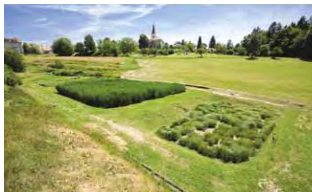
Slika 3: Rastlinska čistilna naprava za čiščenje odpadnih komunalnih voda iz naselja Sv. Tomaž pri Ormožu (foto: Iztok Ameršek).
