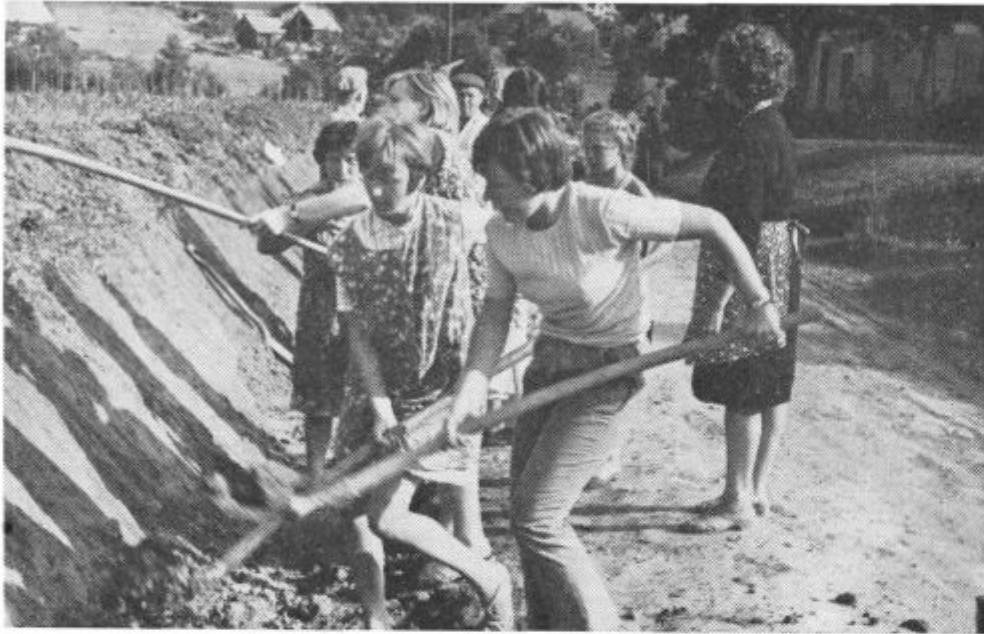
Ravenčani so krepko prijeli za krampe in lopate ter uredili vsa zemeljska dela na šest kilometrov dolgem cestišču
