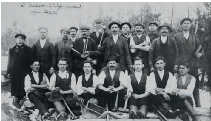
Delavci podjetja Našička ob zgraditvi gozdne železnice Dolnja Lendava–Kobilje okt. 1930. (GML Arhiv)
