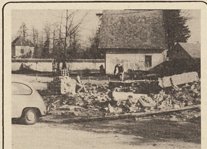
LOVSKI DOM — Ribniški lovci so pričeli v tem mesecu z izgradnjo lovskega doma. Obstoječi objekt stare veterinarske zgradbe na Opekarski cesti so že podrti, sedaj pa dom dobiva dokončno podobo. Lovski dom bo imel dva večja prostora, sejno sobo in hladilnico za ustreljeno divjačino. V letošnjem letu bodo dom pokrili (tako, da bo investicija pokrita), v kolikor pa bo zagnanost lovcev in dovolj finančnih sredstev, pa lahko otvoritev pričakujemo že v prihodnjem letu. (U. B.)
