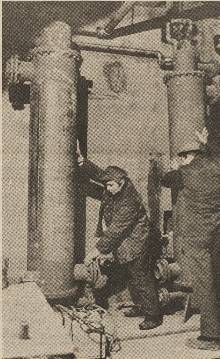
Bloki v stanovanjski soseki Fužine v Ljubljani — montaža toplotne postaje v bloku.
