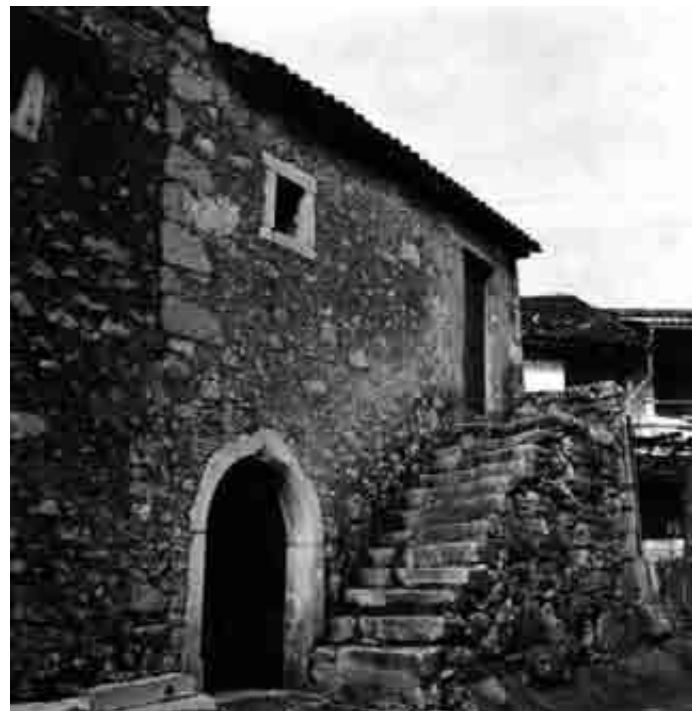
Slika 3: Domačija Dutovlje 85. Minav hram s šilasto obokano kalono v pritlični prostor, ki ima na "ajdovo zrno" porezane robove in zaključek "na oslovski hrbet", na posnetku iz 1978. leta z izvornim ometom. Do kamre v nadstropju so vodile zidane masivne kamnite stopnice. Fotodokumentacija ZVKDS, OE Nova Gorica.
