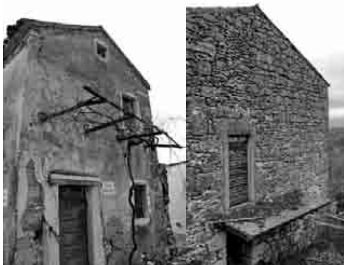
Slika 13, 14: Zapuščen stanovanjski objekt v centru naselja z ometano fasado, kamnitimi okvirji vrat in oken ter leseno oporo za vinsko trto. Objekt je samostojen, z manjšim vrtom ob strani. Zapuščen gospodarski objekt na vstopu v naselje z vidno kamnito fasado in manjšim številom odprtih. Objekt je samostojen in delno vkopan z ločenim vhodom v klet po spodnjem nivoju.
