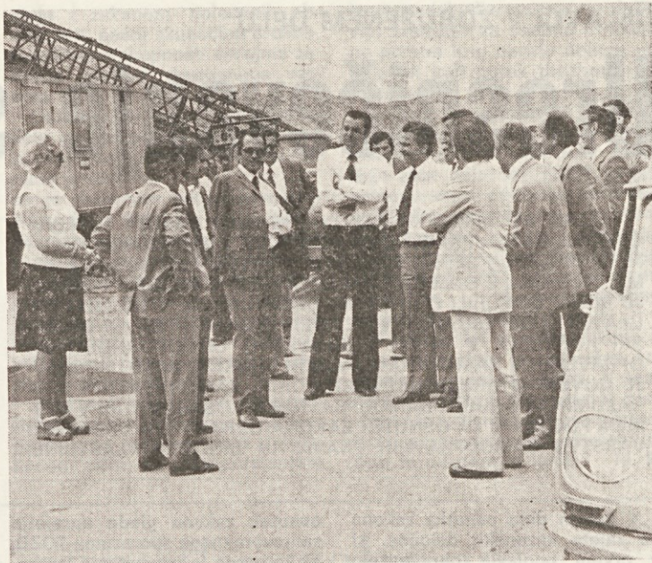
Ob obisku predsednika IS SRS Andreja Marince in Milovana Zidarja, sekretarja za kmetijstvo, gozdarstvo in prehrano na gradbišču vodnega kanala hidrocentrale Srednja Drava 2
