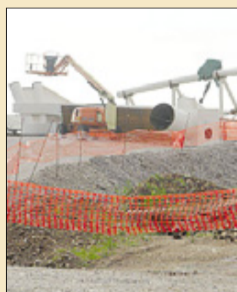
Dela na krožišču pri Štandrežu
