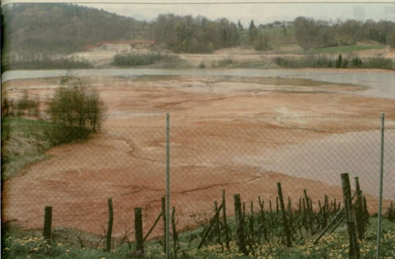
Dela, ki so jih v Cinkarni Celje zadnje tedne opravljali na deponiji Za Travnikom, so imeli po zagotovilih pomočnika direktorja Danija Podpečana dovoljenja. Zgraditi so morali novo servisno cesto ter prestaviti plato za manipulativna dela na višjo lokacijo, saj bi ju sicer kmalu zalila voda, ker je deponija že napolnjena do polovice. Izsušeno deponijsko dno zdaj že zaliva voda, kar zahteva tudi ŠED.
