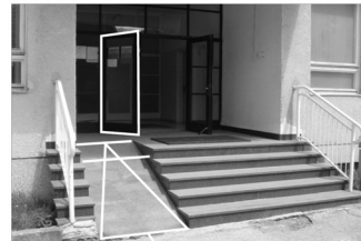
A, pogled na sprednji vhod
