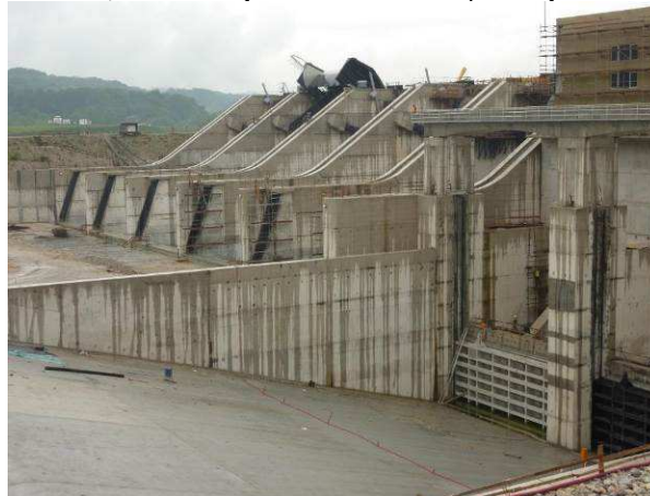
Slika 3 (stanje maj 2016): Glavna gradbena dela na strojnici in prelivnih poljih HE Brežice so praktično končana, montiran je tudi velik del »težke« opreme. Pretočni trakti so zaprti in na celotnem objektu poteka montaža opreme. Preusmeritev Save je bila izvedena avgusta 2016, prva delna polnitev bazena pa novembra 2016.
