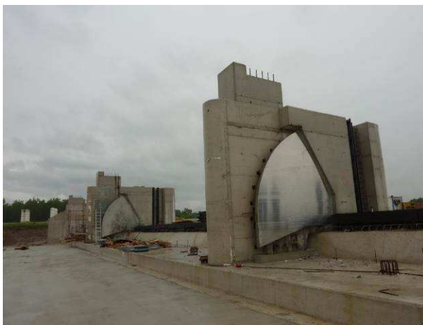
Slika 2 (stanje maj 2016): Prvi postanek ogleda je bil gradbišče visokovodnega preliva na levem bregu bodočega bazena. To bo prvi objekt takšne vrste v Sloveniji, podoben je načrtovan tudi v bazenu HE Mokrice.
