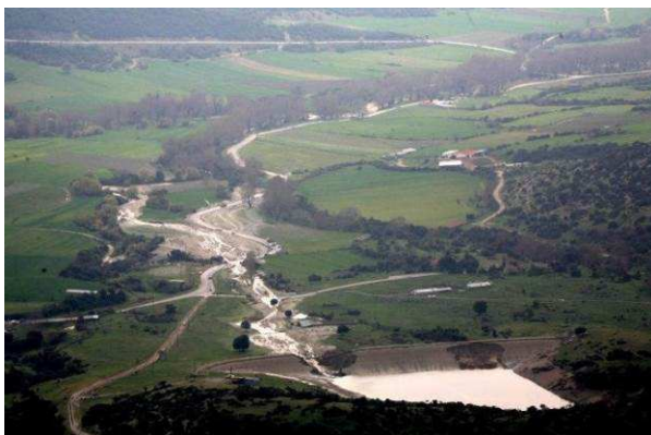
Slika 1: Porušitev pregrade Sparmos (marec 2016).
