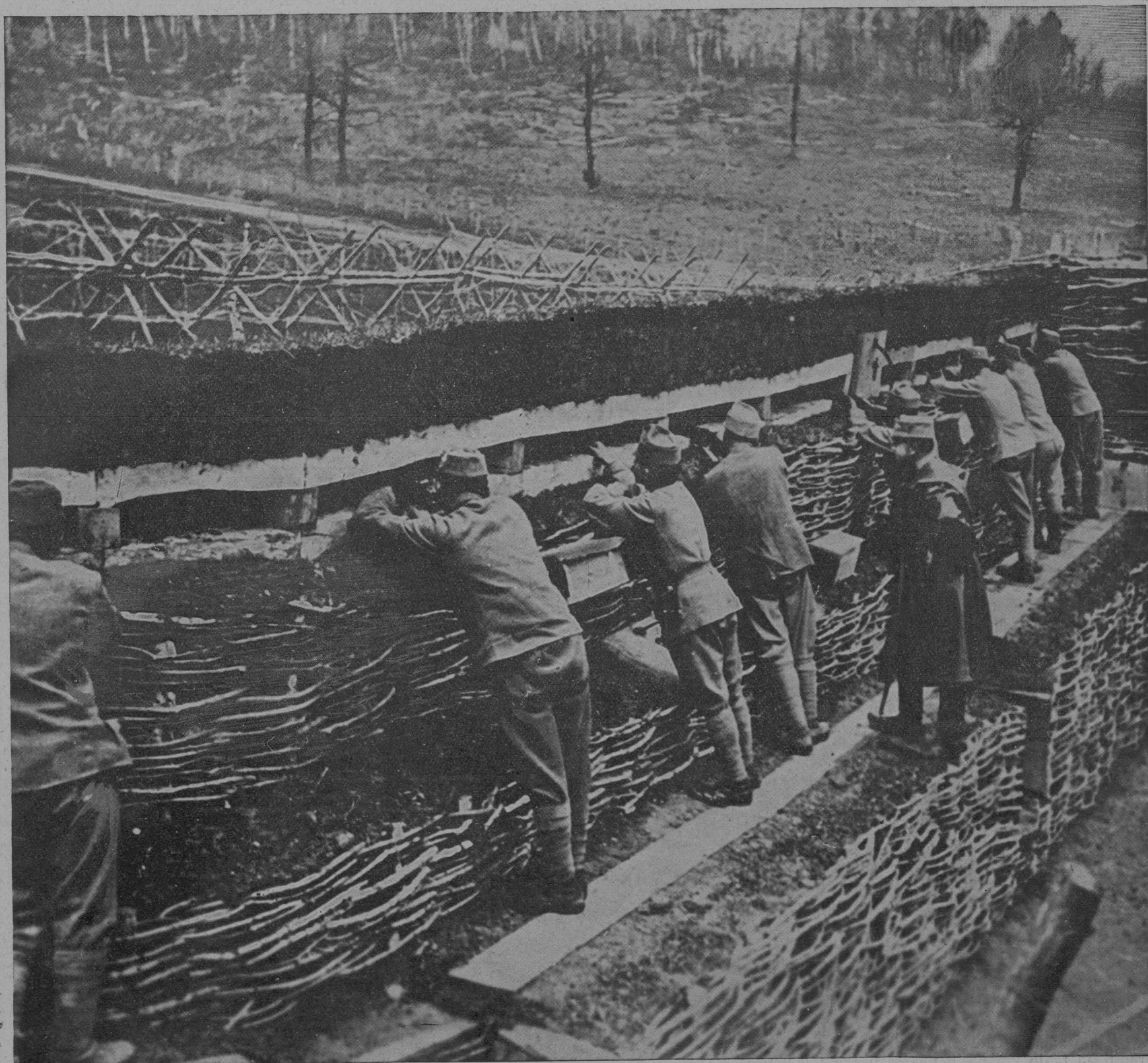
Vzorno zgrajeni strelski jarki avstro-ogrške vojske na fronti: Zgoraj so španski vitezi, da ne more sovražnik blizu; spodaj stoje s puškami pred strelskimi odprtinami naši vojaki in opazujejo nasprotnika. Za vojaki poveljujoči častnik.
