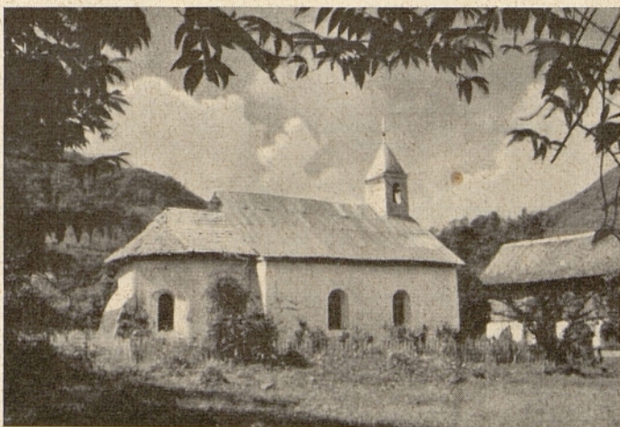
Altes Kirchlein in Pozuzo, erbaut um 1870.
