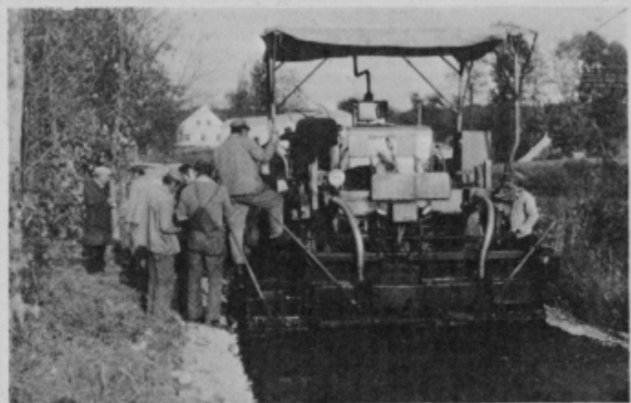
Delavci cestnega podjetja polagajo zadnje metre asfalta v Levajncih. Foto: mš
