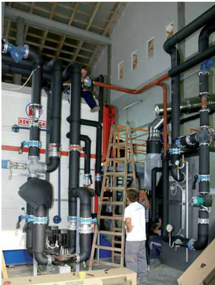
Še zadnja dela na velikem kotlu
