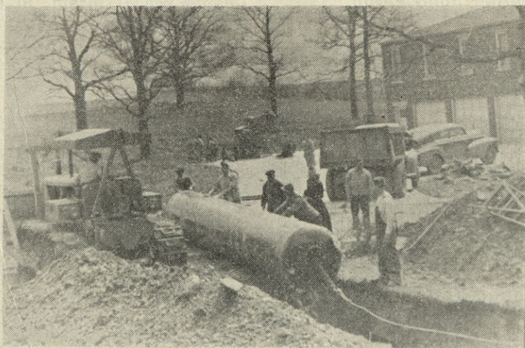
Lemontski frančiškani smo morali dobiti novi tank za vodo, ker stari je že imel preveč lukenj. Na sliki vidite, kako ga v zemljo spravljamo. Slika je bila vzeta aprila meseca.
