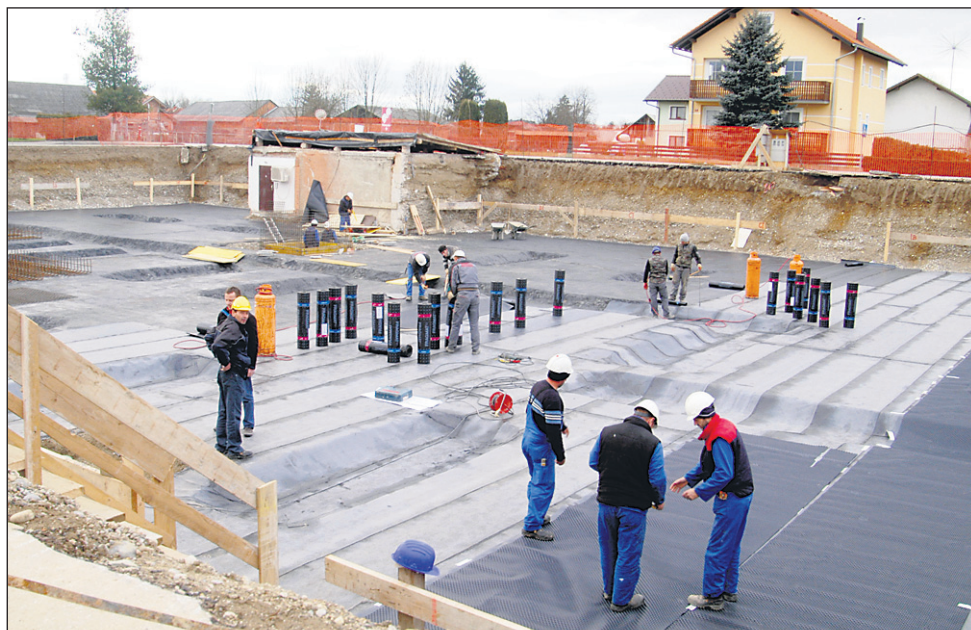
Foto: M. Ozmeč V centru Markovcev je ogromna gradbena jama, v kateri so prejšnji teden delavci polagali izolacijo temeljev za zgradbo bodočega poslovno-stanovanjskega objekta.
