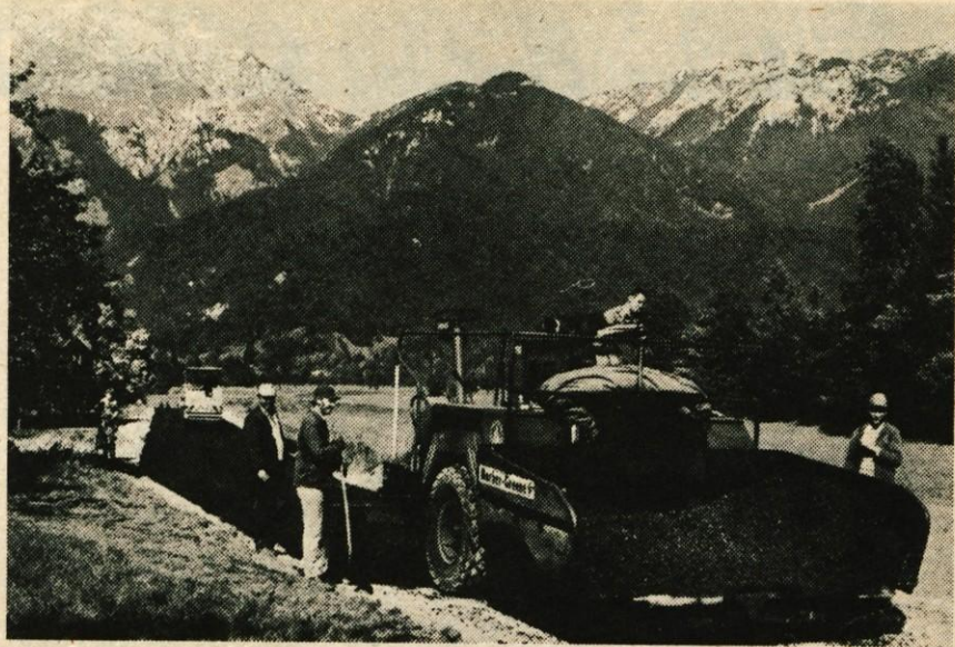
Delavci Cestnega podjetja iz Kranja so začeli pretekli četrtek vgrajevati asfalt na cesti med Zgornjo Belo in Bašljem. Z asfaltom so prekrili 1700 metrov dolgo makadamsko cestišče od mostu na Zgornji Beli do križišča na vrhu klanca v Bašlju. (jk) — Foto: F. Perdan
