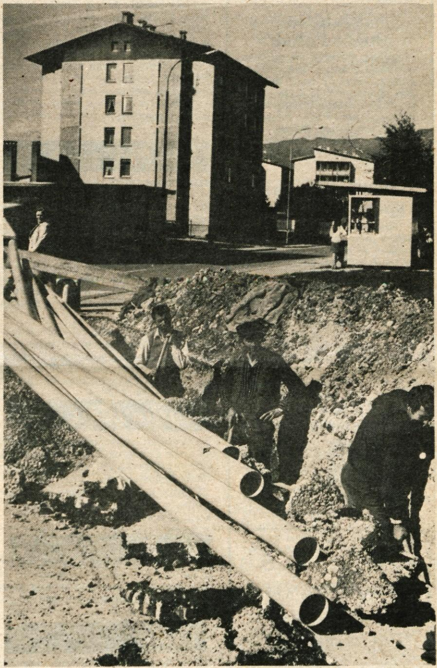
Podjetje za PTT promet Kranj te dni v skladu z razvojem nekaterih naselij v kranjski občini povečuje zmogljivosti za telefonsko mrežo. Z deli hitijo, da jih ne bi presenetilo slabo vreme. — A. Ž. — Foto: F. Perdan
